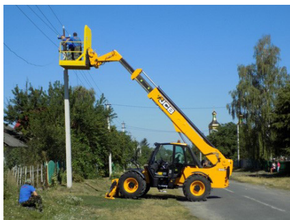
Проводяться роботи з освітлення вулиці села. Фото надане автором
