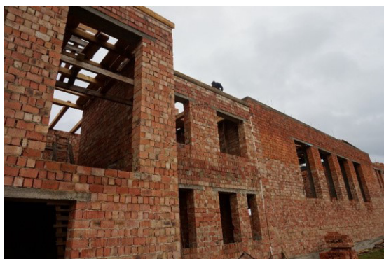
Будівництво спортзалу для НВК та школи в Сторожинці
