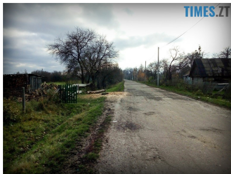
Дорога, відремонтована сучасним методом (територіальна громада Кишин). Виглядає ще не ідеально, але їхати по ній вже нормально
