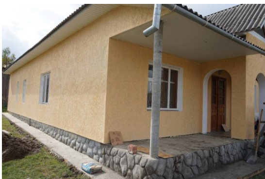
Капітальний ремонт амбулаторії в Зруб-Комарівцях
