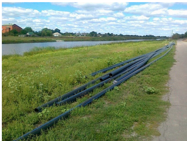
Прокладання водогону в Пришибській ОТГ
