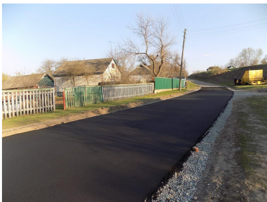
Відремонтвані дороги у Сергіївській ОТГ
