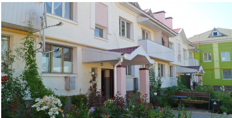
Один із відремонтованих будинків у Пришибі | Фото: energolife.info
