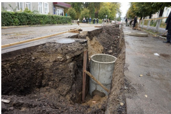
Капітальний ремонт каналізаційної системи у Сторожинці
