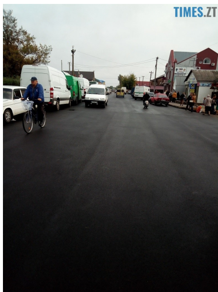
Вулиця Київська в Олевську після ремонту: проведене розширення, вирішена проблема заторів та ремонту полотна
